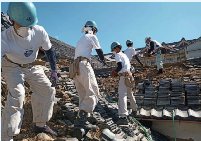
旧本芝詰所の解体作業
