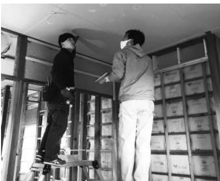
2階天井のパテ埋め作業
